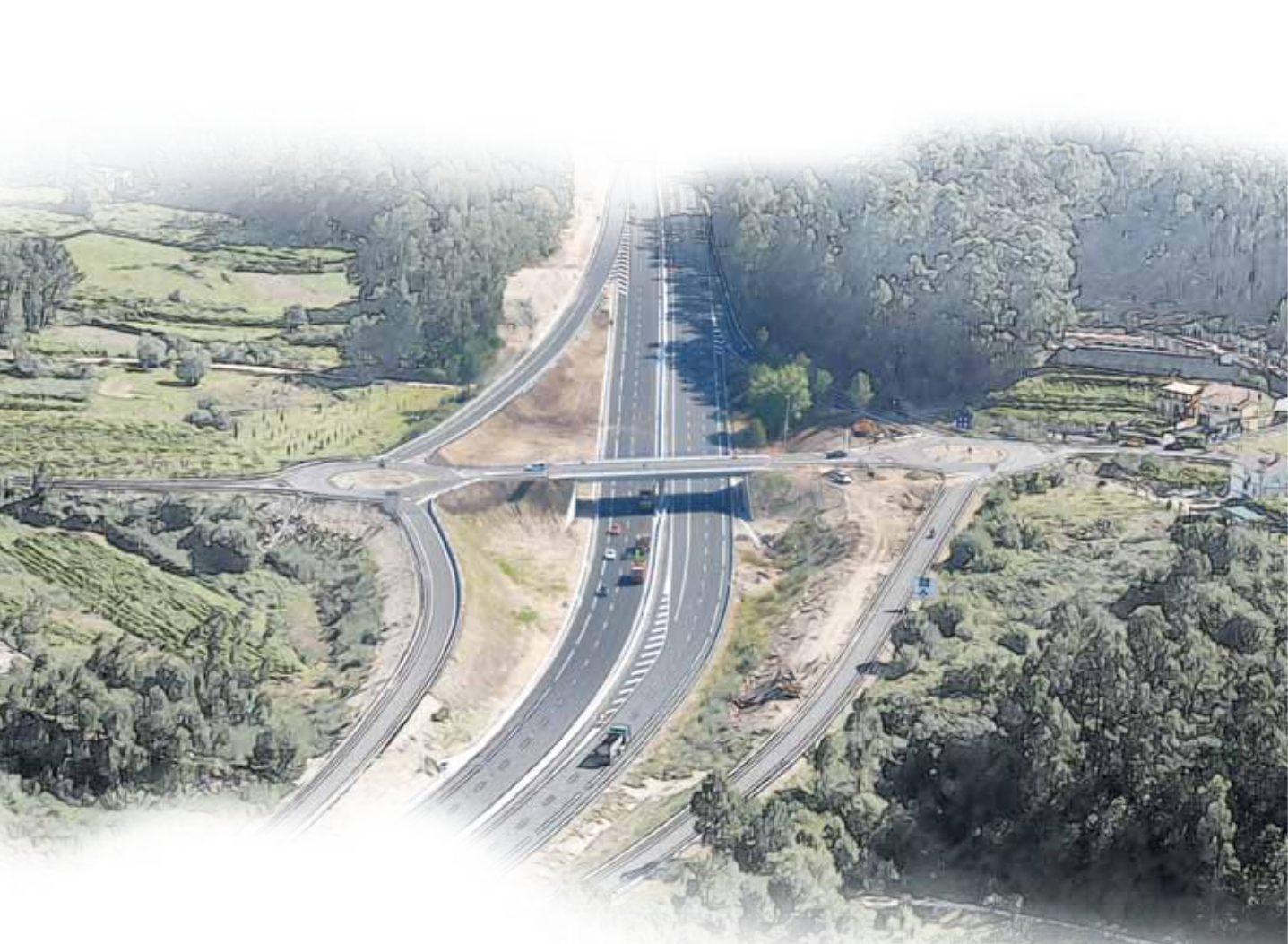
Autovía del Salnés, España
