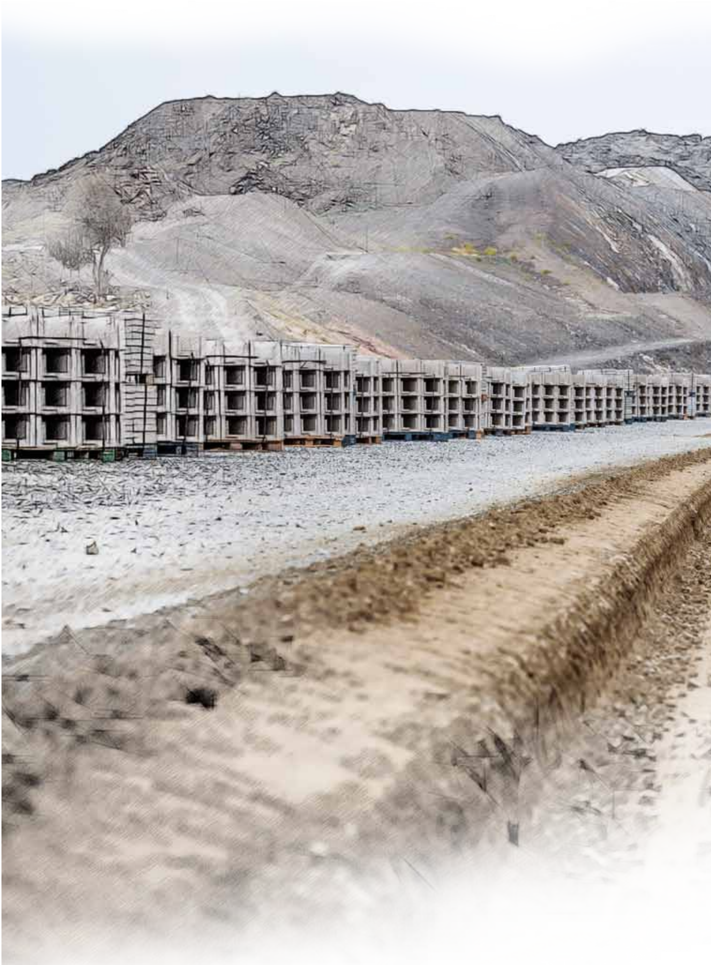
Línea de Alta Velocidad La Meca-Medina, Arabia Saudí
