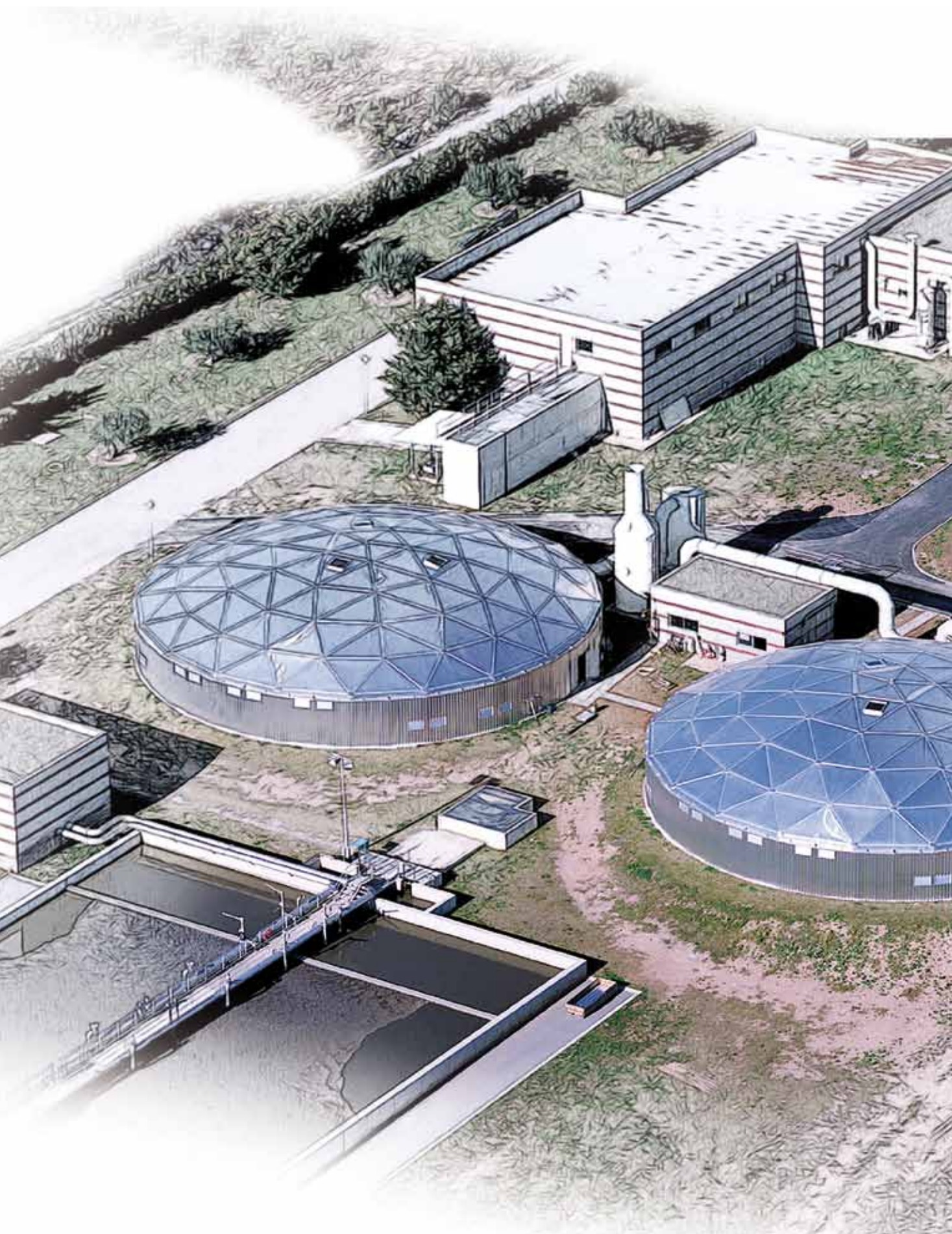
EDAR Torredembarra, Tarragona, España
