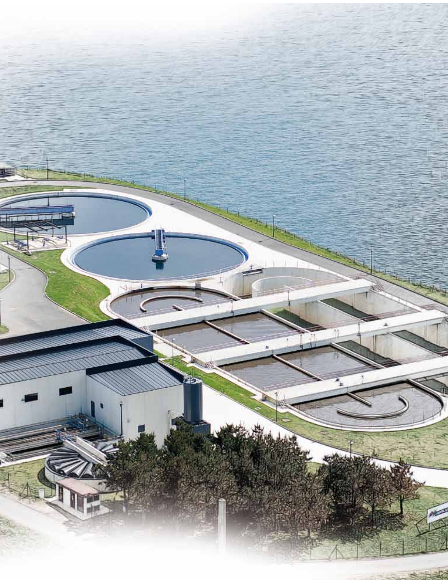
EDAR Ares-Fene, A Coruña, España
