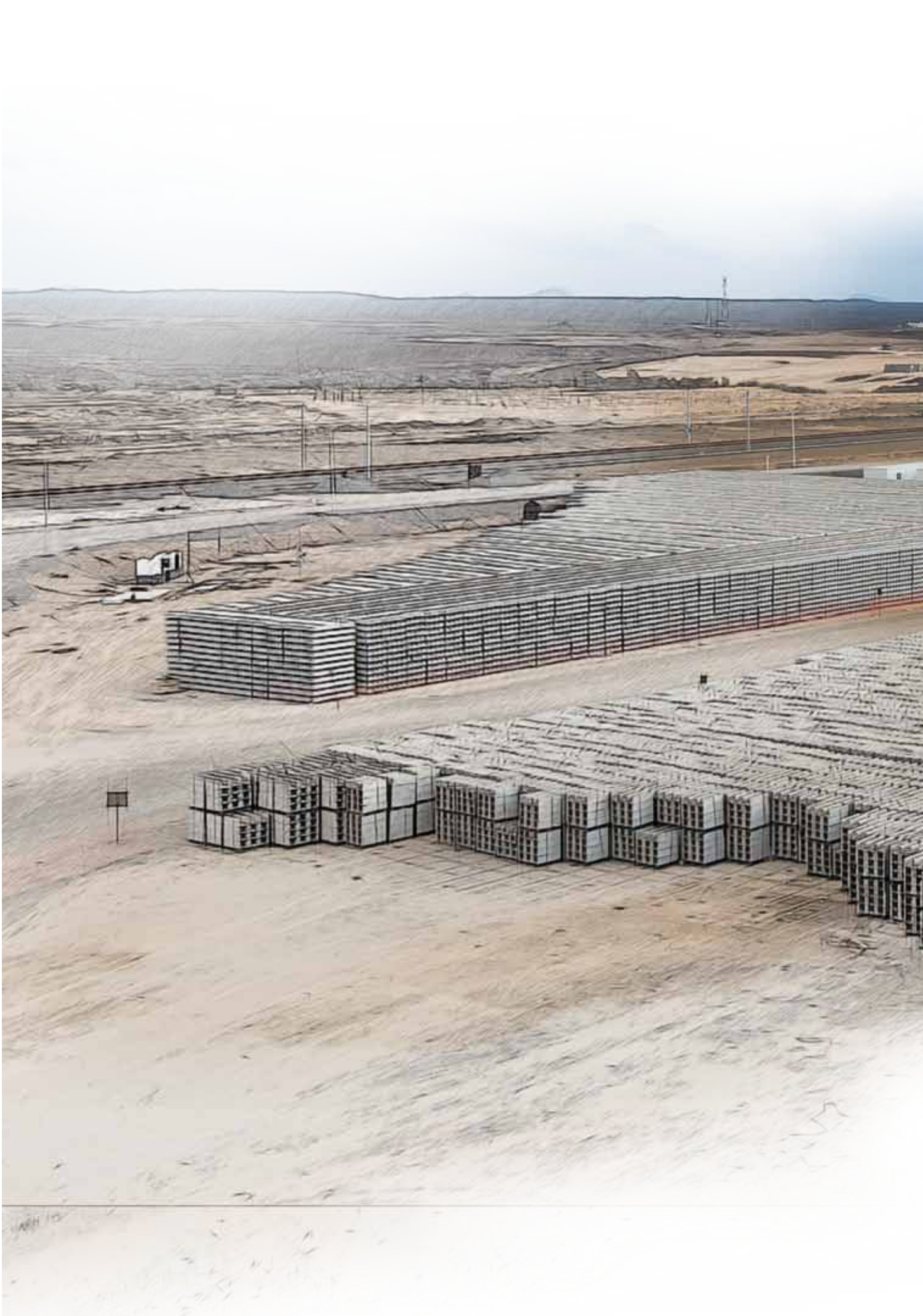
Línea de Alta Velocidad La Meca-Medina, Arabia Saudí
