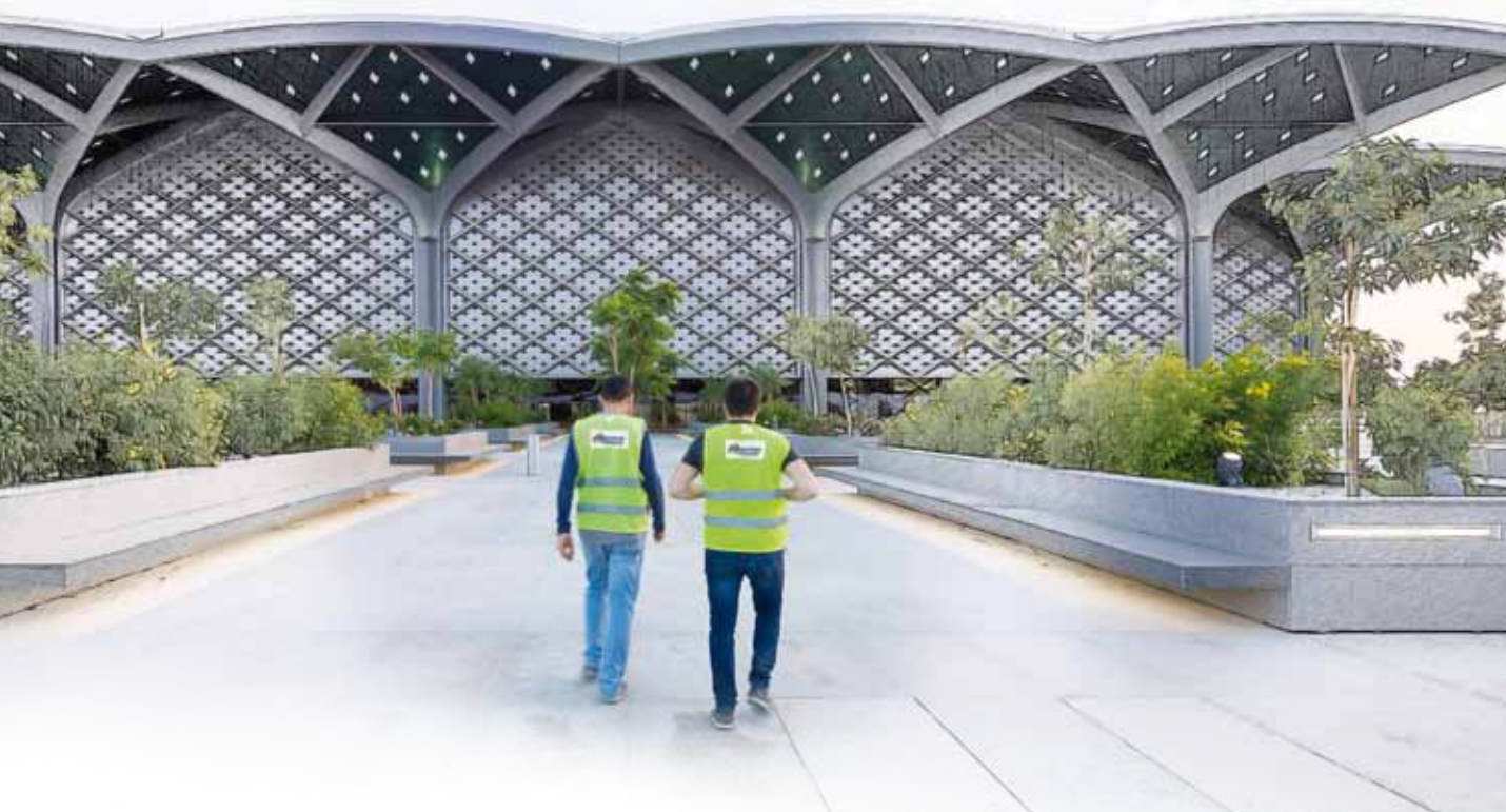
Línea de Alta Velocidad La Meca-Medina, Arabia Saudí
