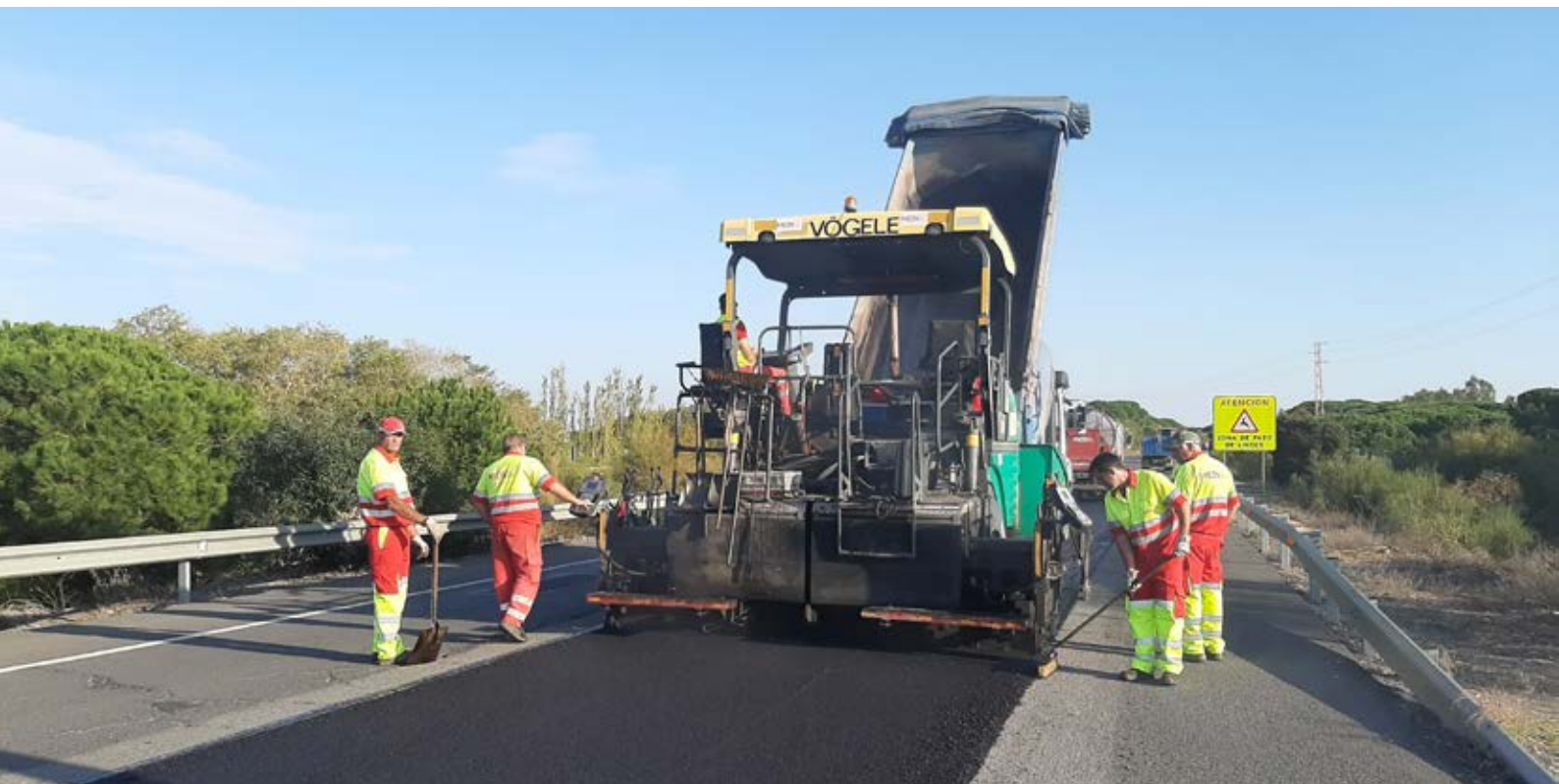
Conservación y explotación de carreteras en Huelva, España | Maintenance and operation of roads in Huelva, Spain
