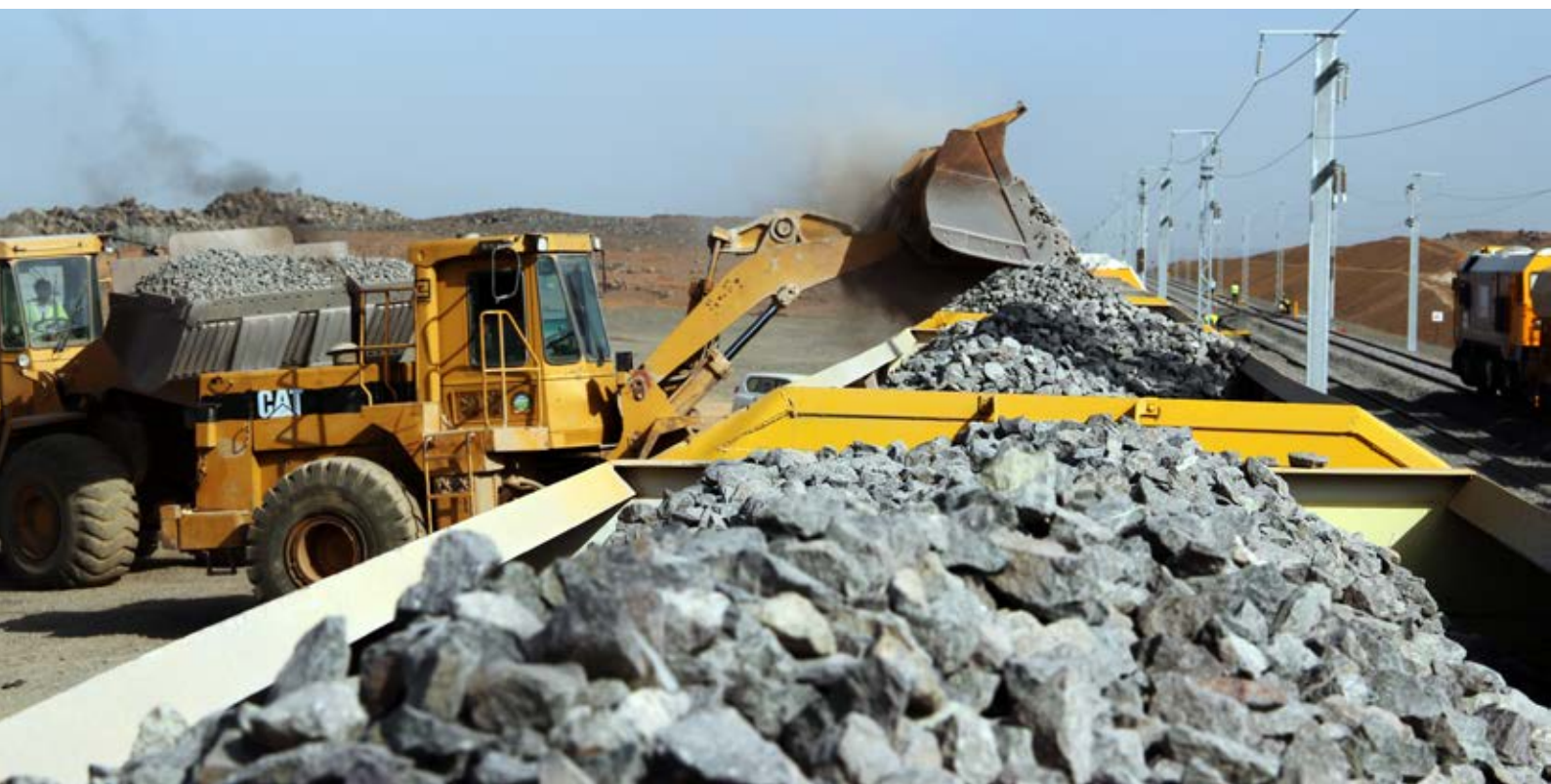
Línea de Alta Velocidad La Meca-Medina, Arabia Saudí | The Mecca-Medina High-Speed Railway Line, Saudi Arabia
