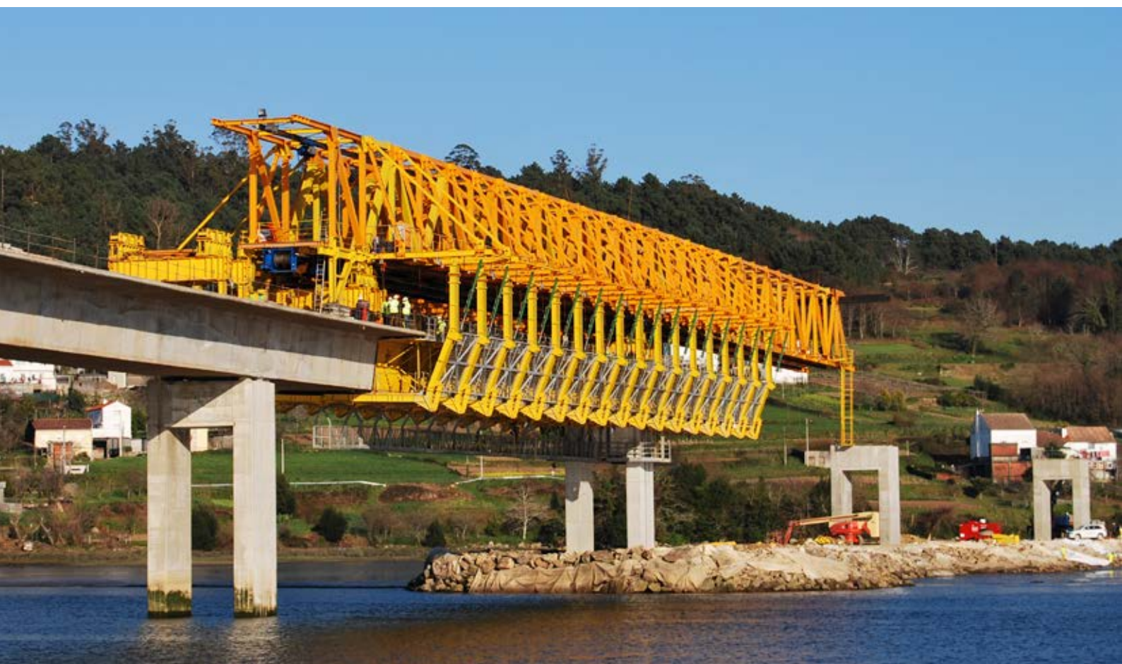
Muros Noia, Puente autocimbra. España | Muros Noia, bridge. Spain
