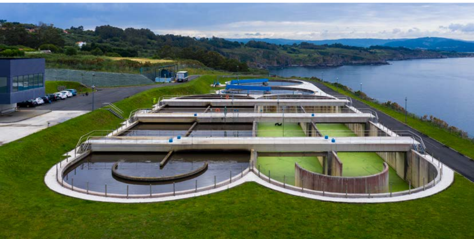
Construcción y operación EDAR Ares, España | Construction and operation of a wastewater treatment plant in Ares, Spain
