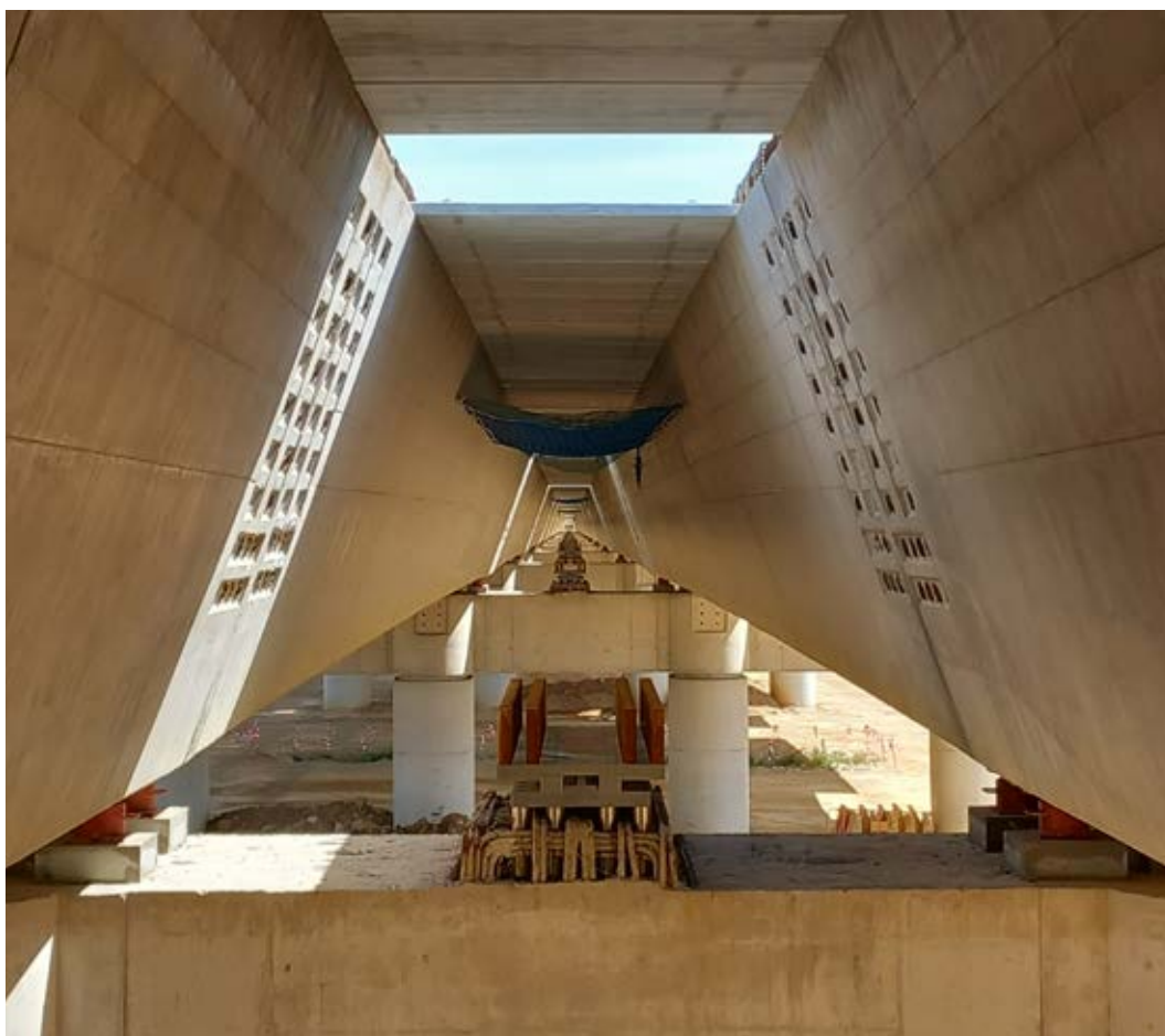
Corredor Mediterráneo de Alta Velocidad Murcia – Almería, España Murcia – Almería High-Speed Railway Line, Spain
