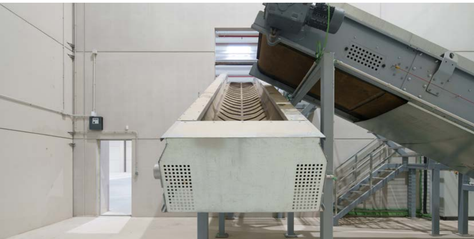
Planta de Compostaje Verín, España | Verín Composting Plant, Spain
